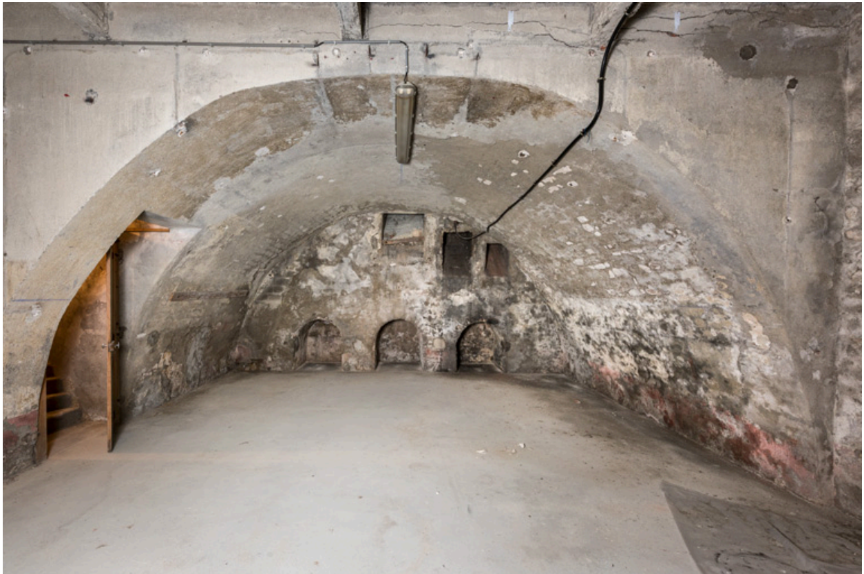
Caves nord : vue depuis l'est.
