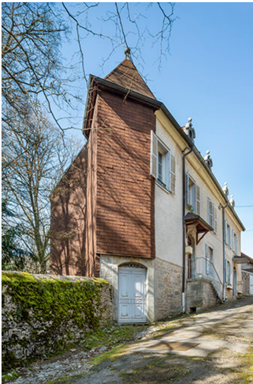
Maisons canoniales (7 escaliers de Saint-Anatoile). Vue depuis le sud-est.
