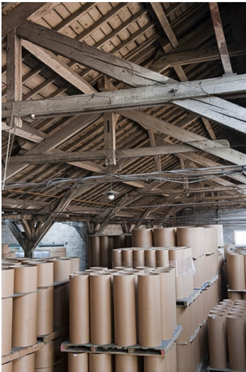
La charpente du magasin industriel (cadrage vertical).
