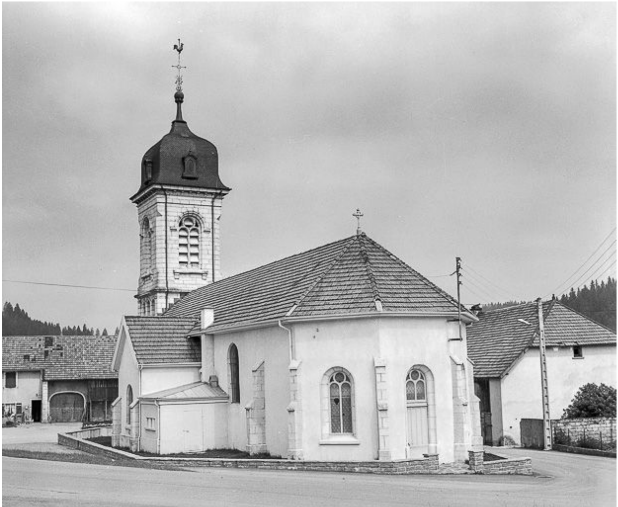
Façades postérieure et latérale droite.
