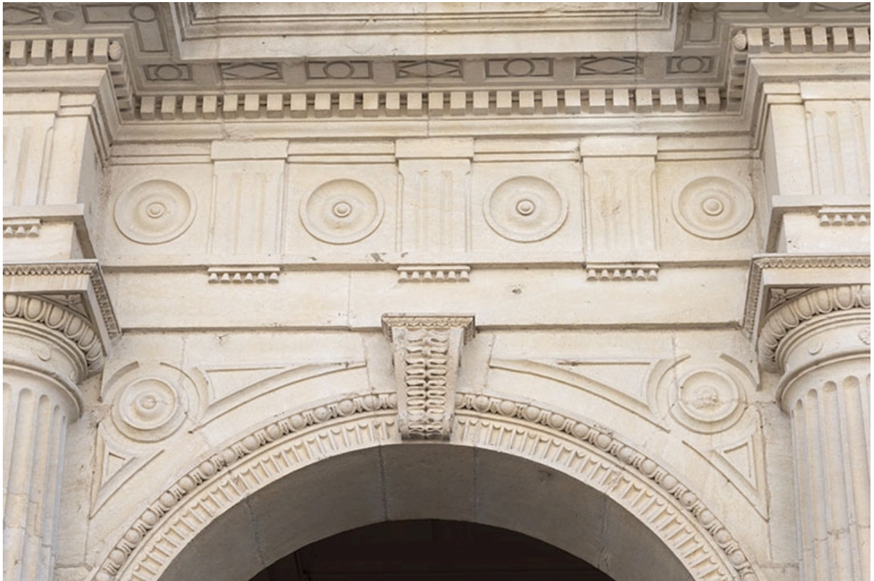
Façade antérieure, rez-de-chaussée : entablement.
