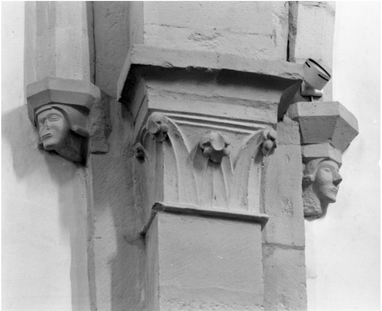
Nef, culots et chapiteau à gauche entre les 2e et 3e travées (n° 8 sur le plan de localisation).
