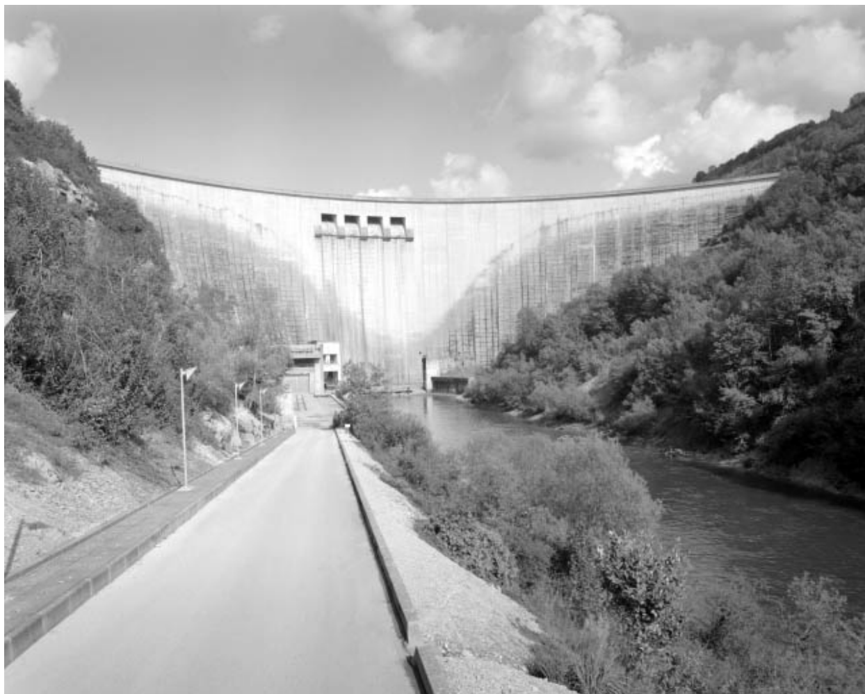
Le barrage, vu d'aval.
