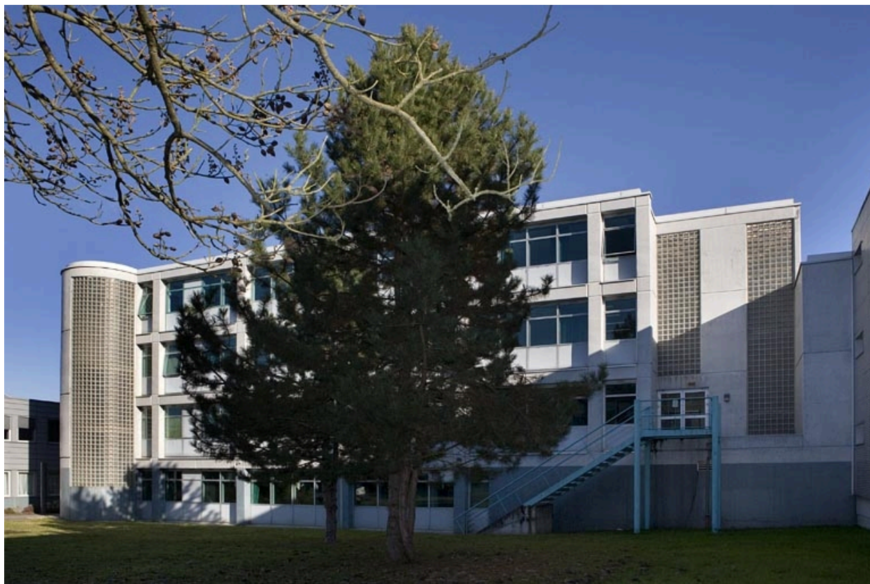
Bâtiment B. Vue de la façade antérieure.
