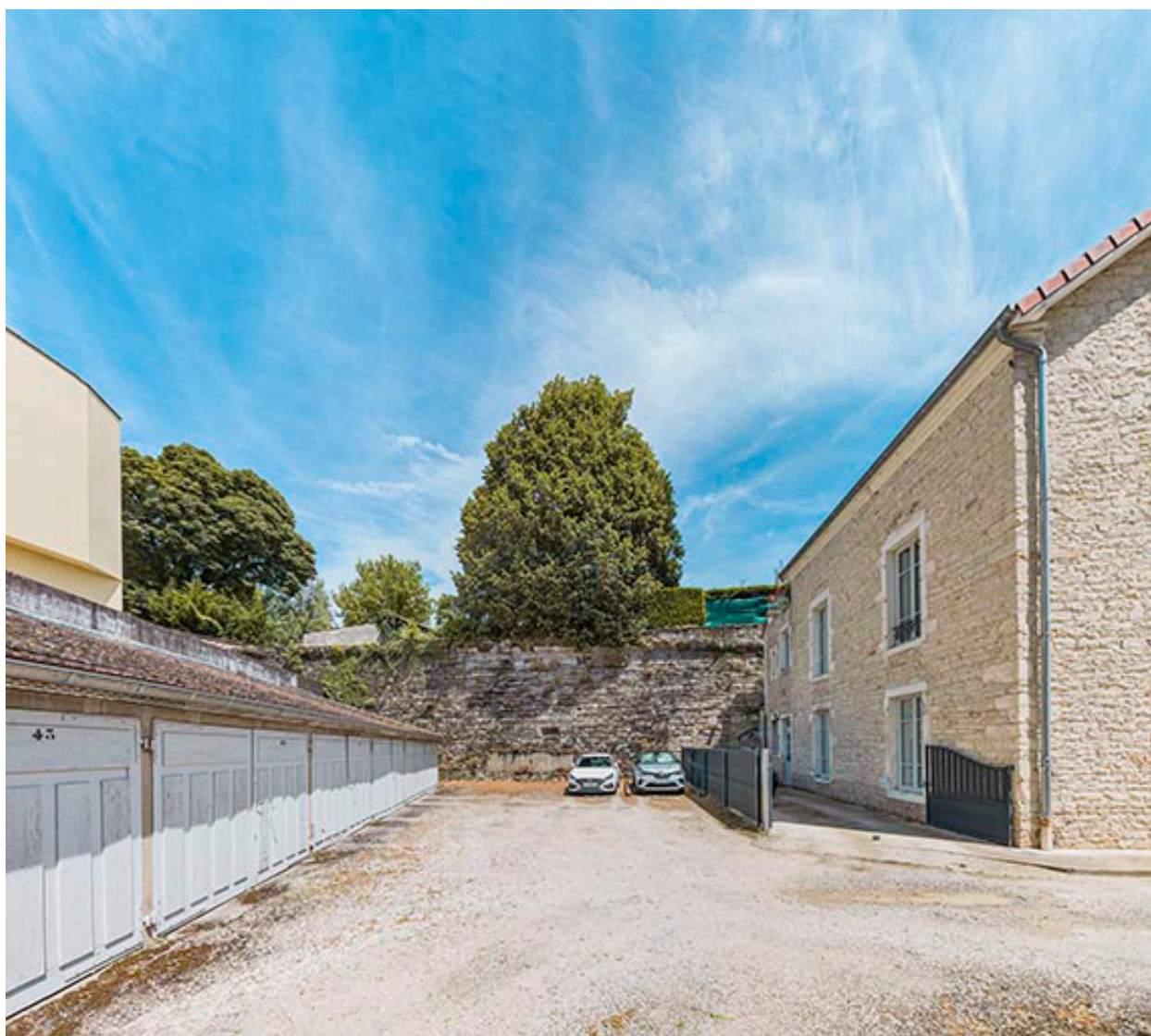
Portion du bastion Saint-Paul.
