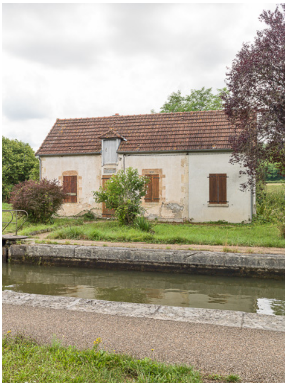
Vue de la maison éclusière.
