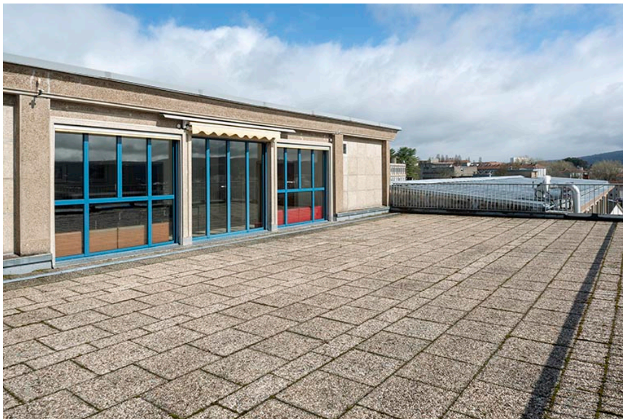
1er étage, corps central : terrasse et cantine.
