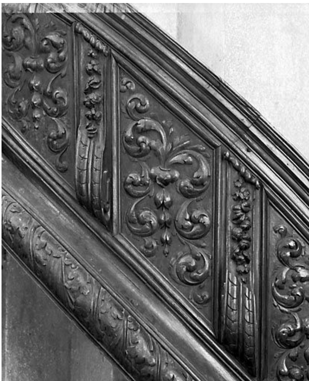
Détail de la rampe.
