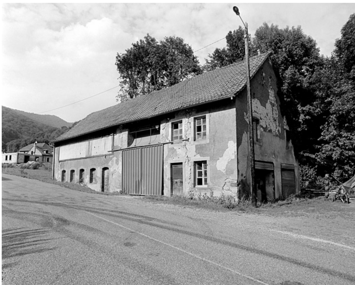
Bâtiment d'eau depuis le sud.
