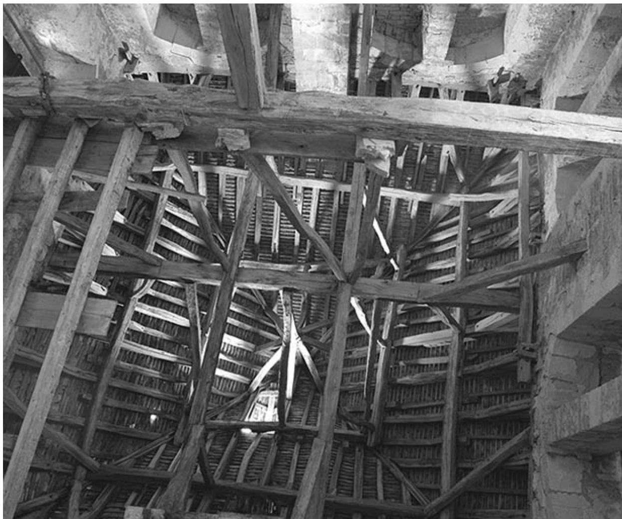
Charpente de la tour.
