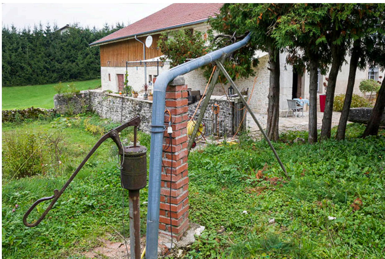
Citerne, pompe et tuyau d'amenée d'eau.
