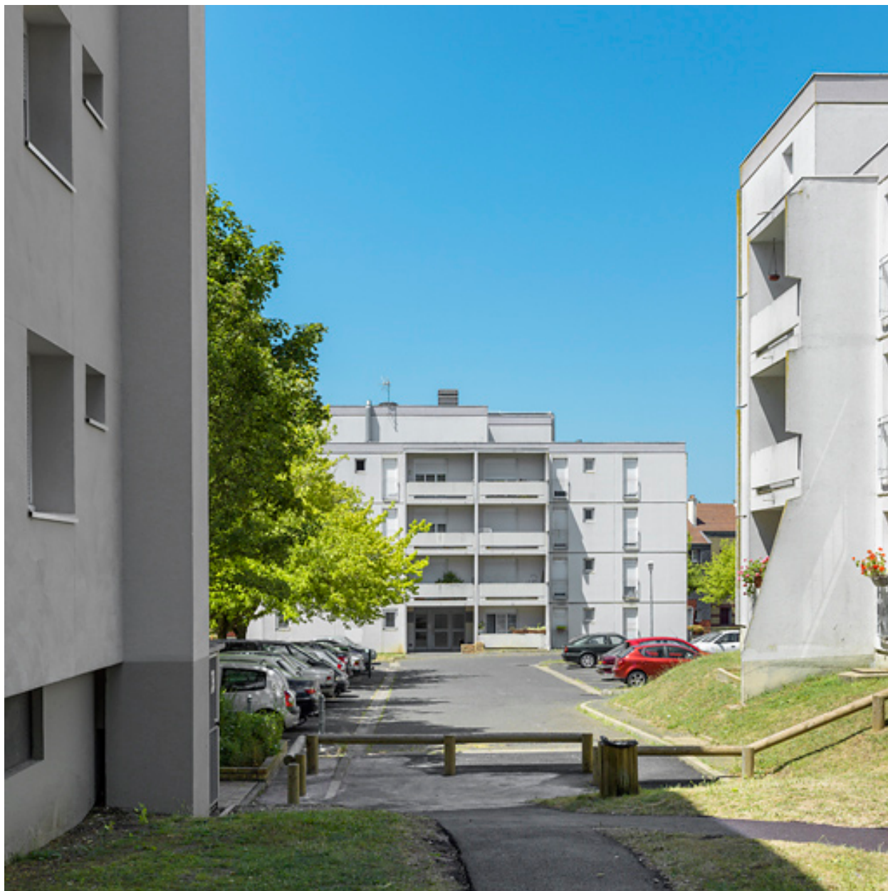
Bâtiment 27, façade antérieure.
