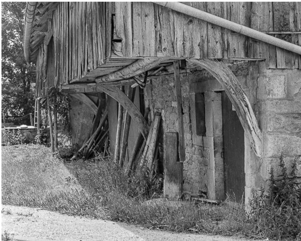
Galerie en bois protégeant un mur goutterot.
