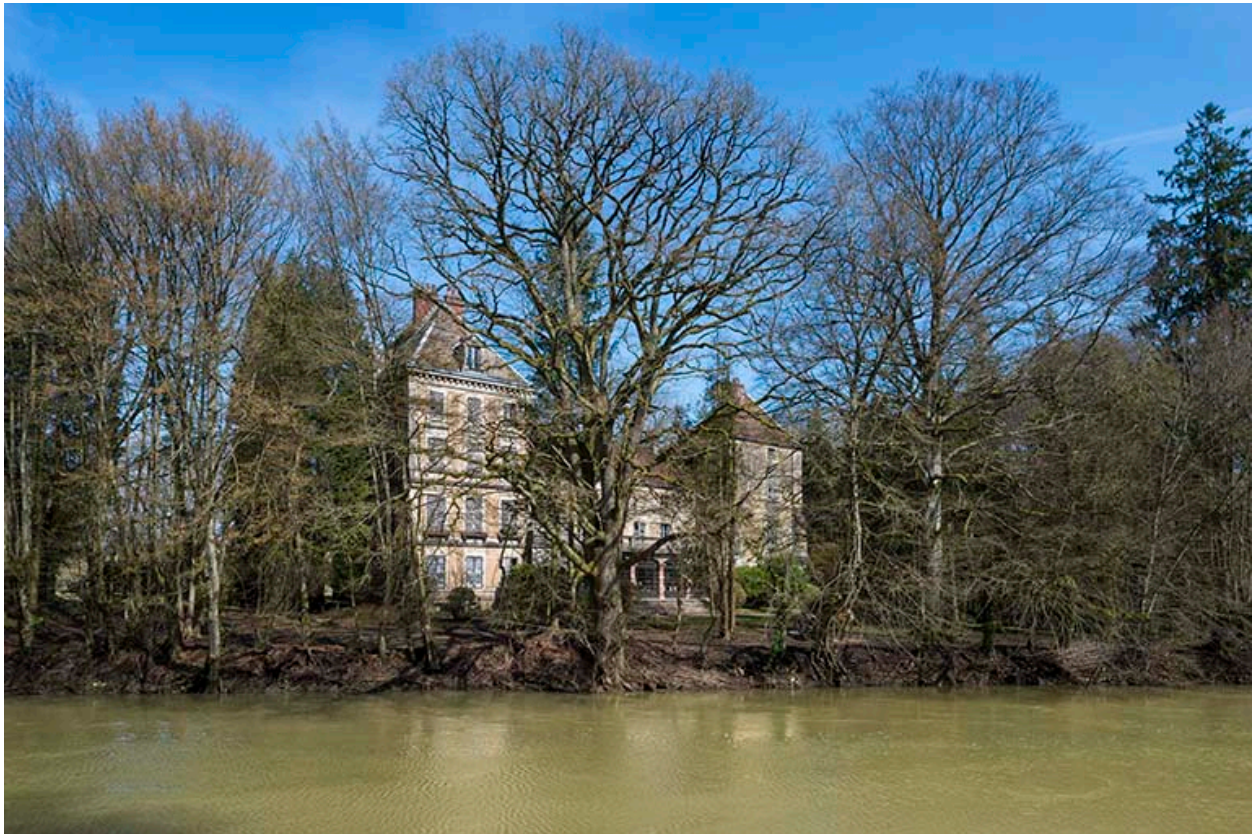
La façade sud-ouest depuis la rue du Moulin rouge.
