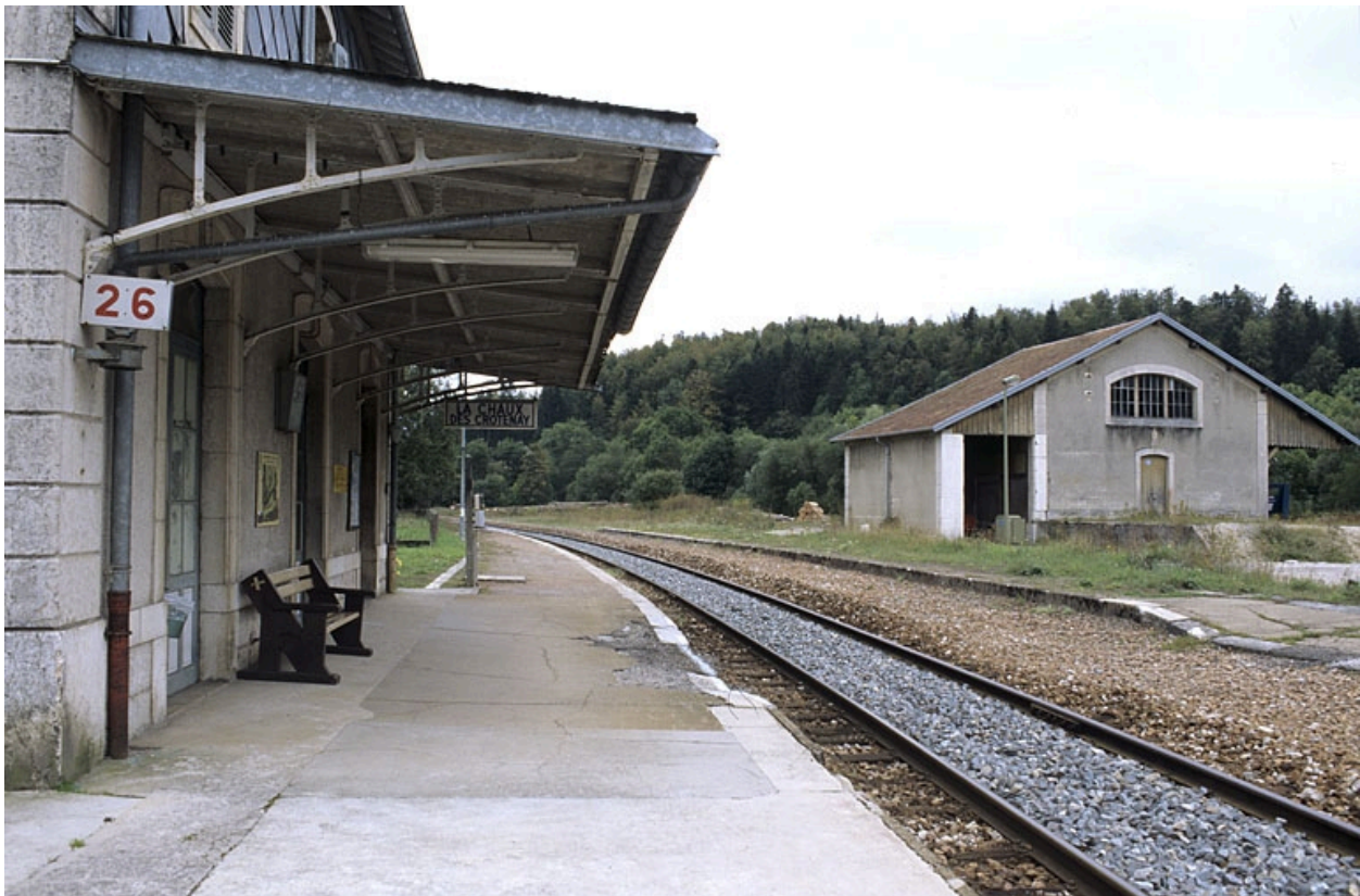
Quai des voyageurs, auvent et entrepôt commercial.
