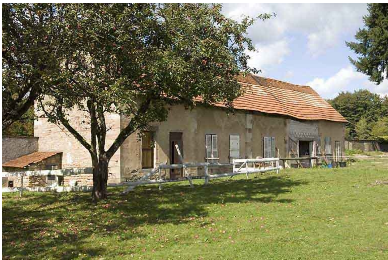
Logement ouest et parties agricoles.
