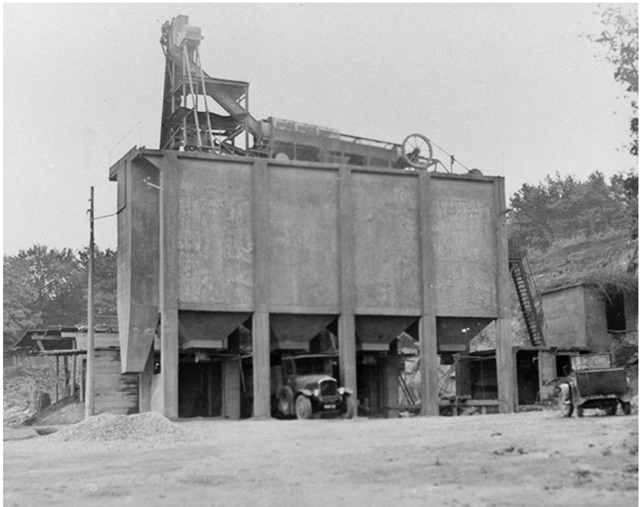
Poste de concassage (C) vu de l'ouest, 1931.
