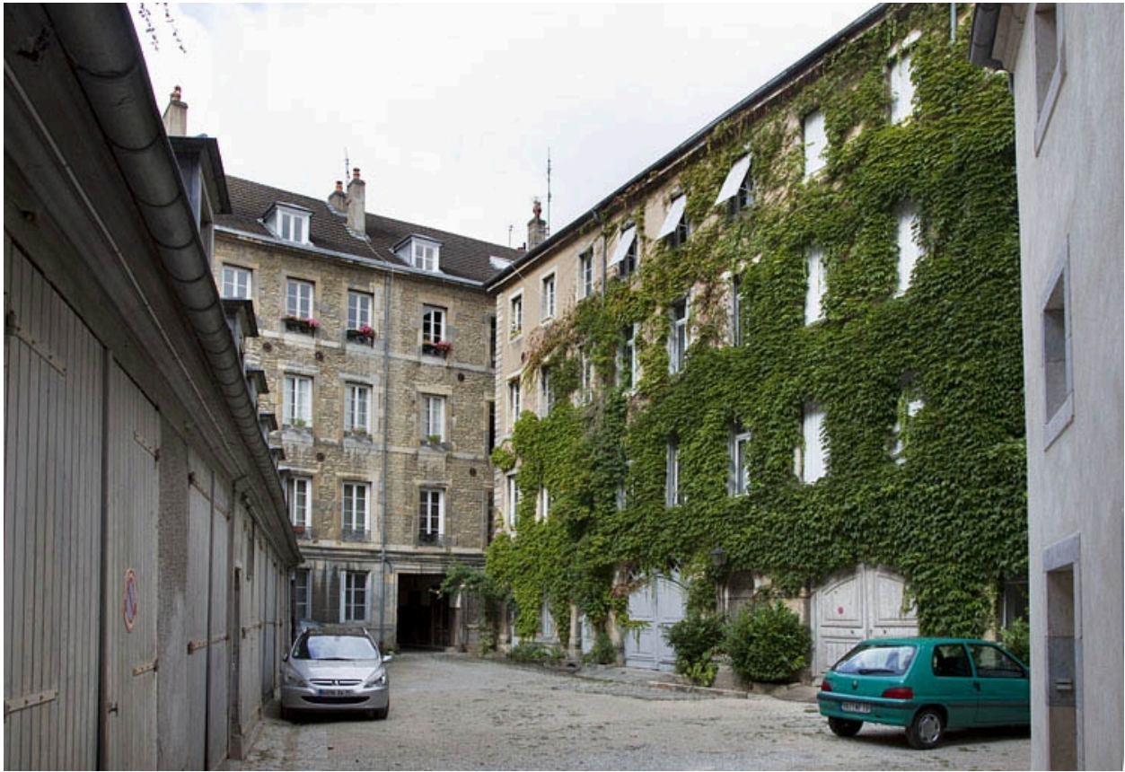
Vue d'ensemble de la façade postérieure du logis principal et du premier logis secondaire, depuis le fond de la cour.
