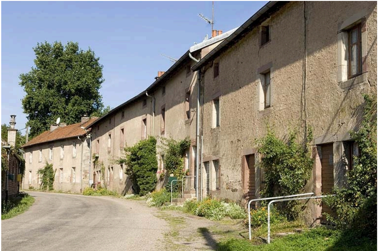
Façades de logements ouvriers (R.D. 304).
