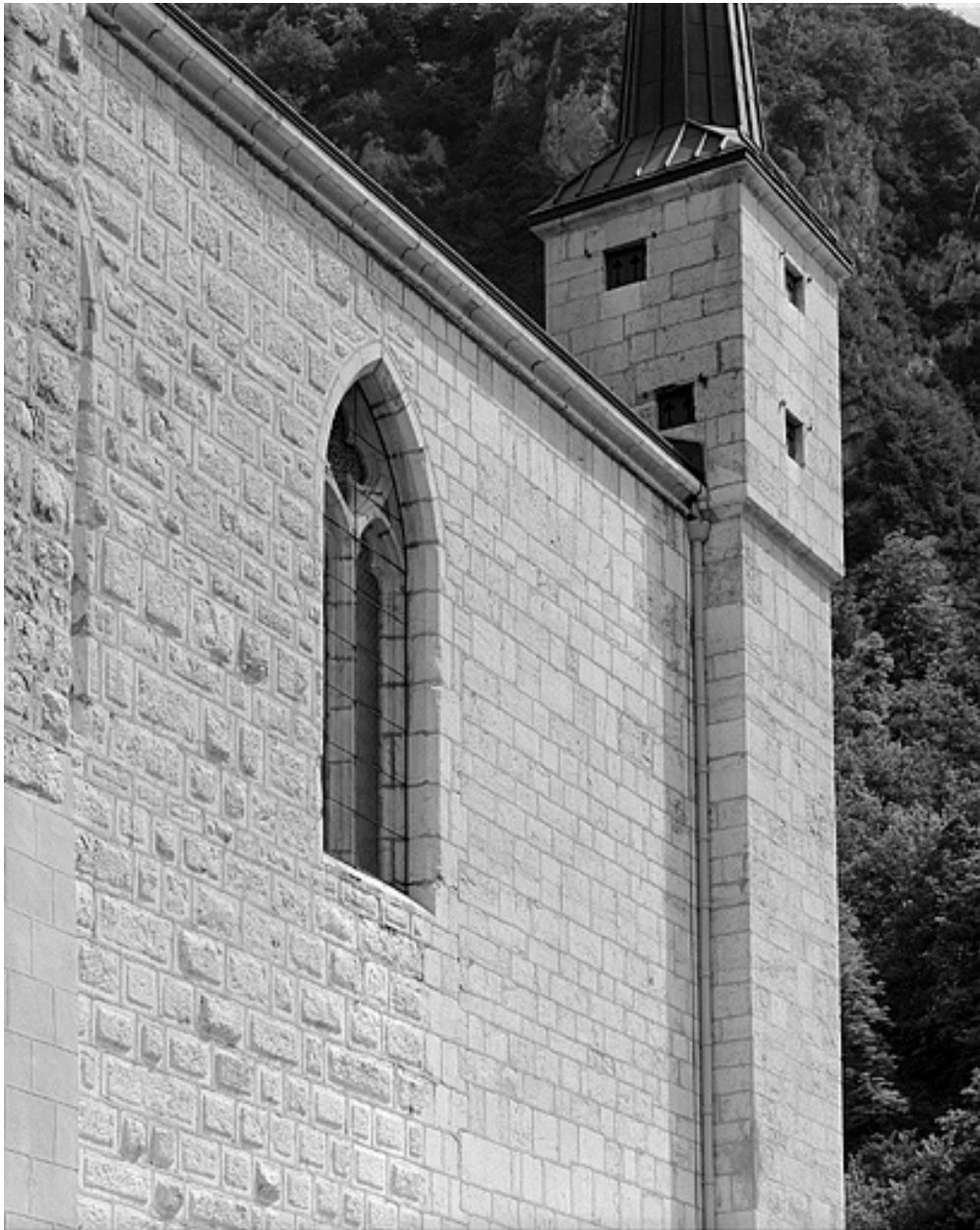
Détail du parement extérieur à l'extrémité du collatéral sud (partie supérieure).
