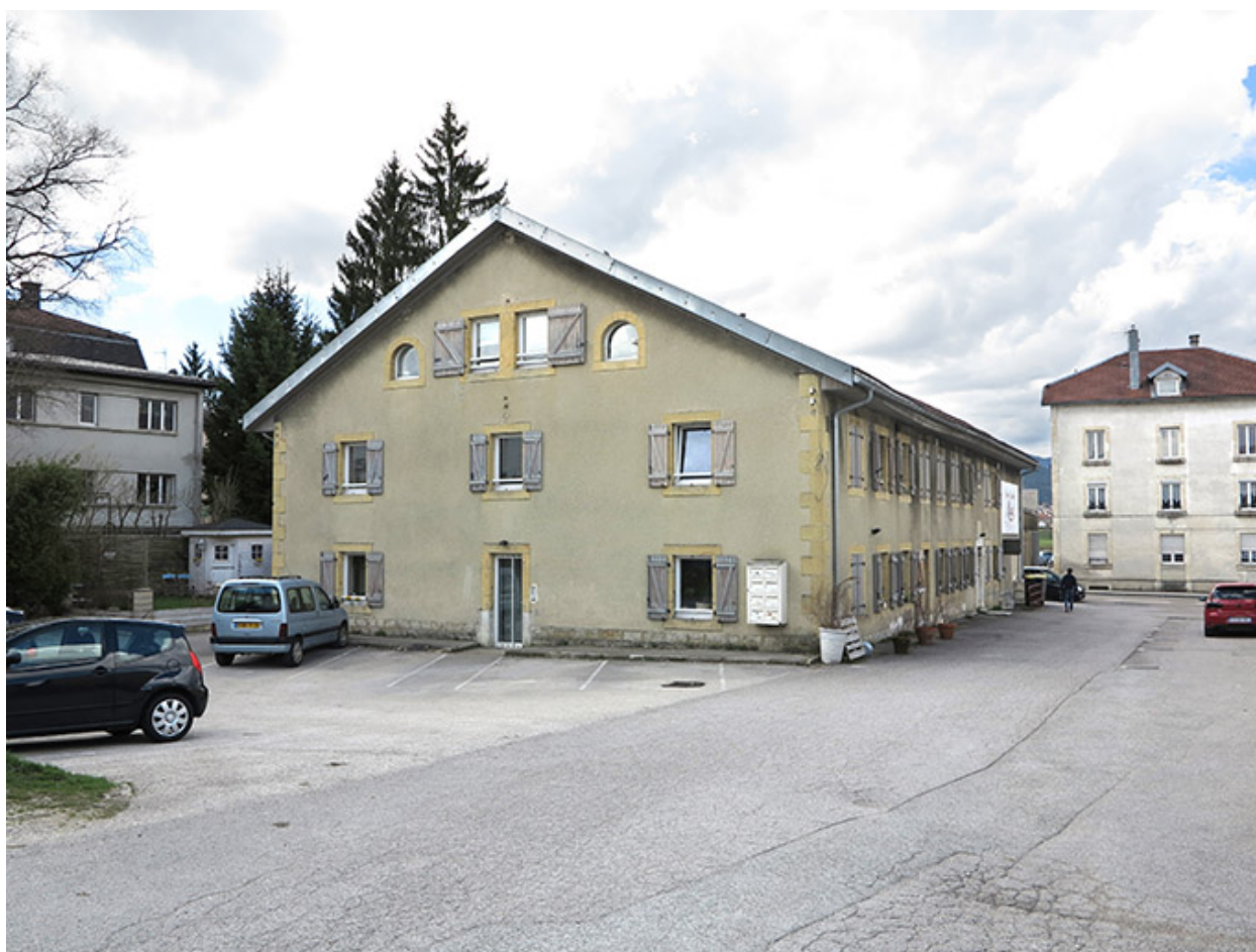
Façades postérieure et latérale gauche.
