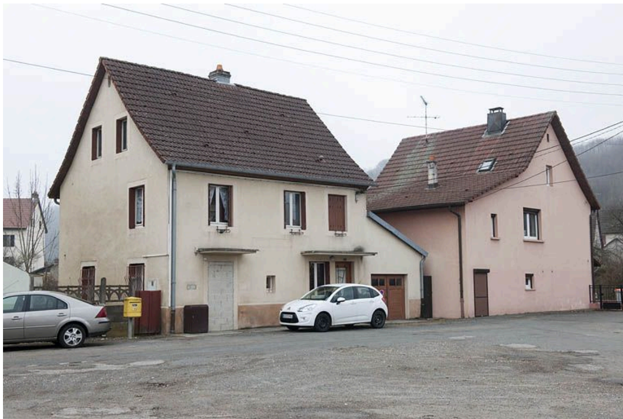
Maisons individuelles rue de la Poste.
