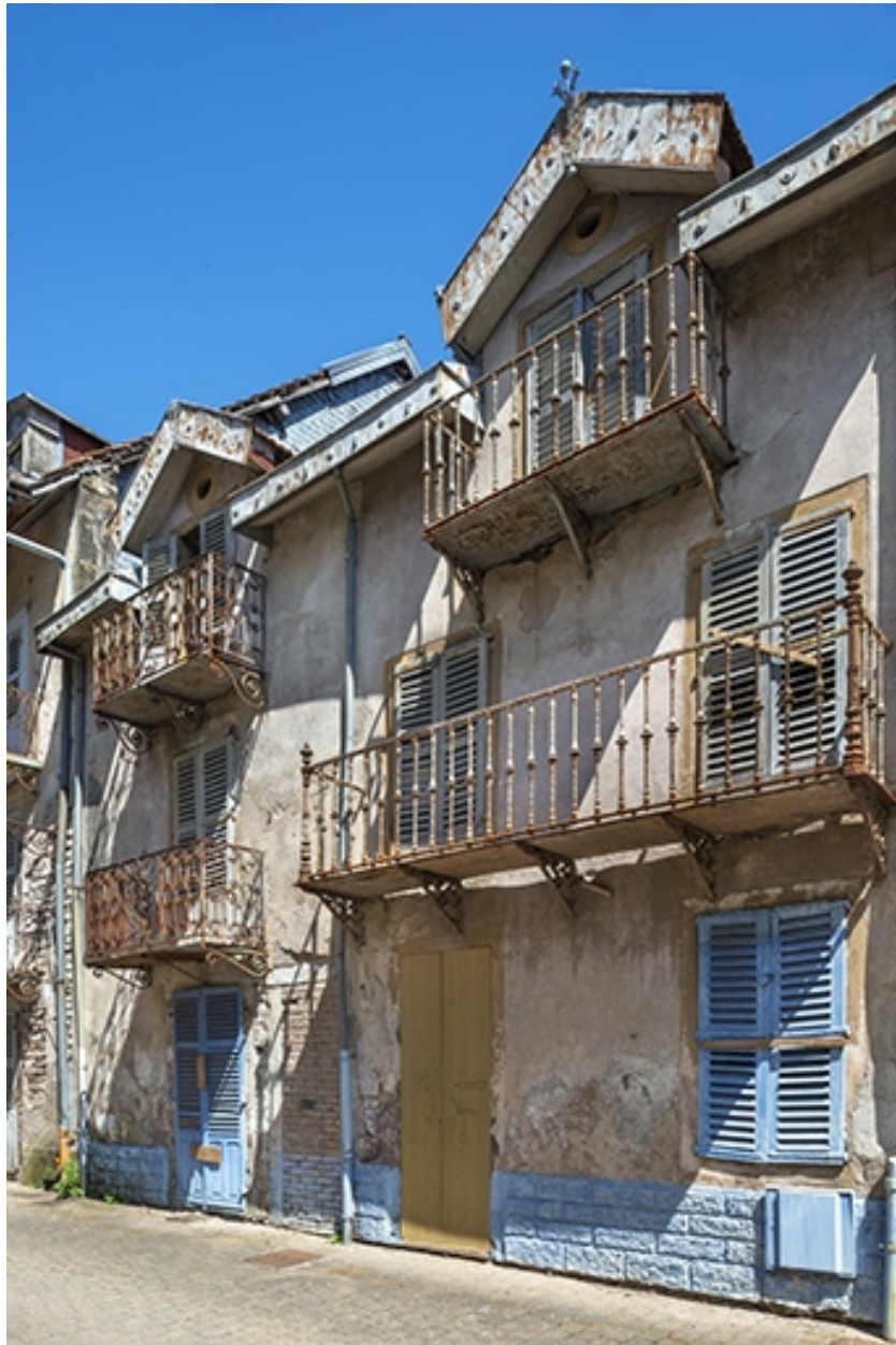
Balcons de l'ancienne maison.
