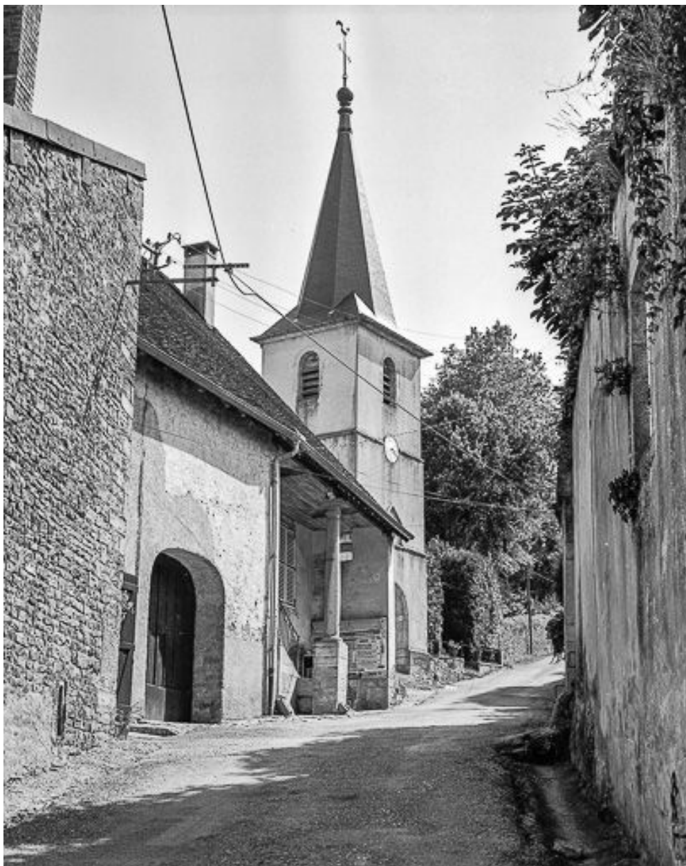
Maison de vigneron située rue de l'Eglise.
