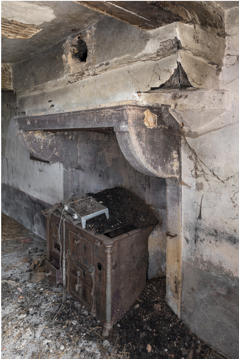
Vue de trois-quart de la cheminée. Pièce unique du rez-de-chaussée.
