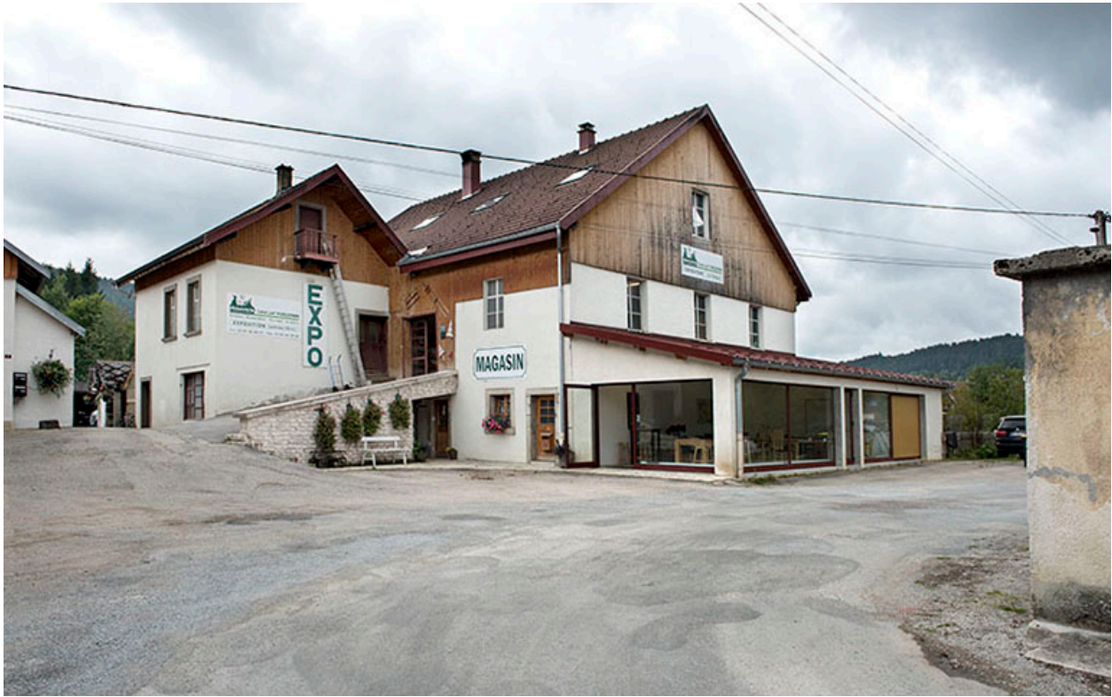
Taillanderie et tournerie Vuillemin (le Pré Rondot) : tournerie de tabourets et ébénisterie.
