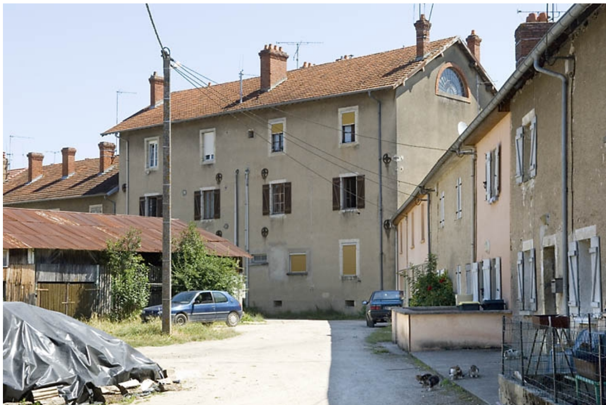
Façade ouest du logement ouvrier sur cour.
