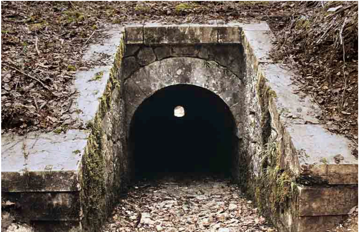
Aqueduc : tête amont (est).
