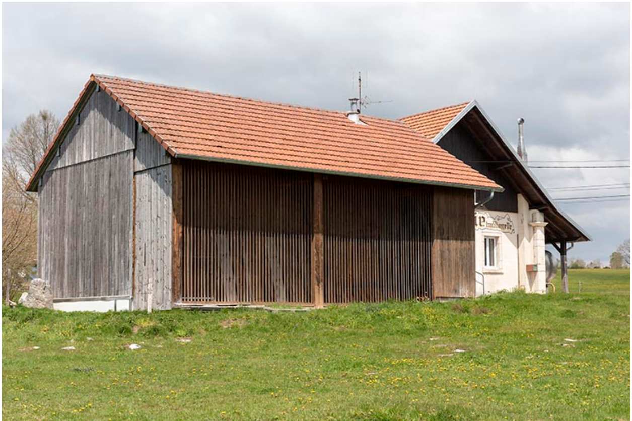
Pièce d'affinage récente, depuis le sud-ouest.
