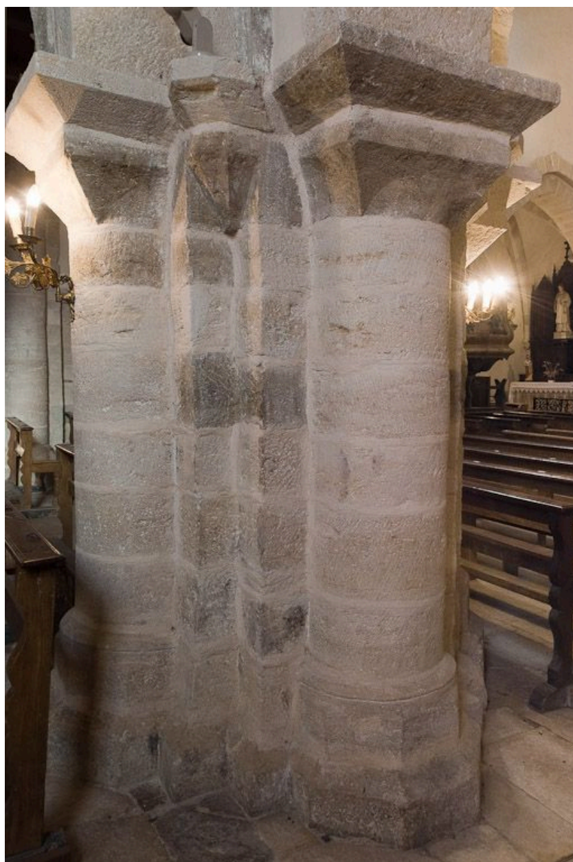
Premier pilier entre la nef et le bas-côté droit.
