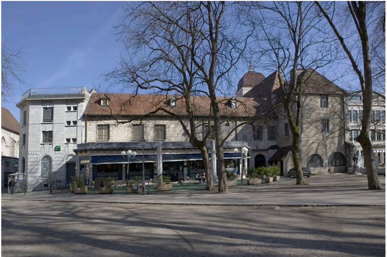
Vue d'ensemble de la façade postérieure.
