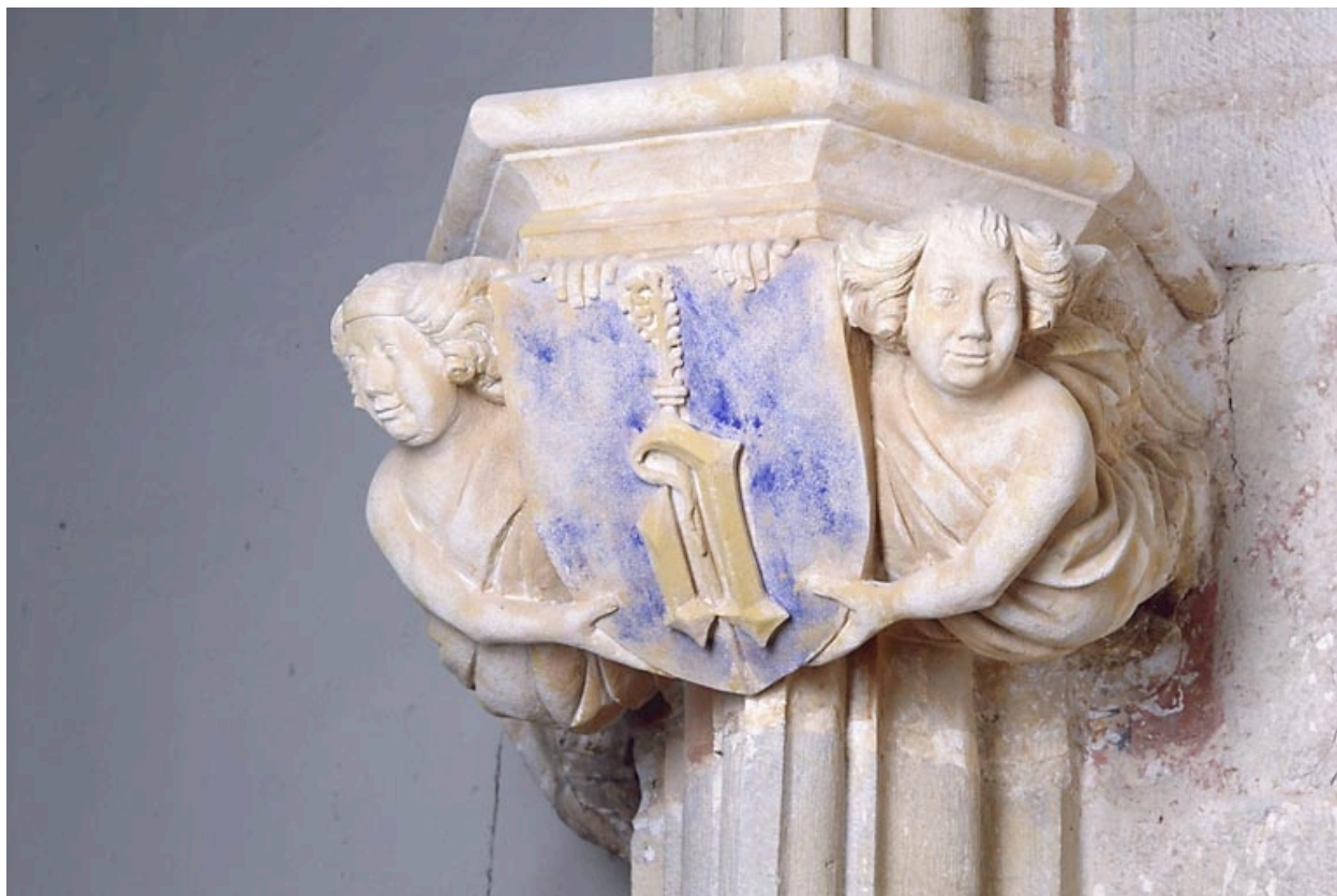
Console nord-est, vue de trois quarts.
