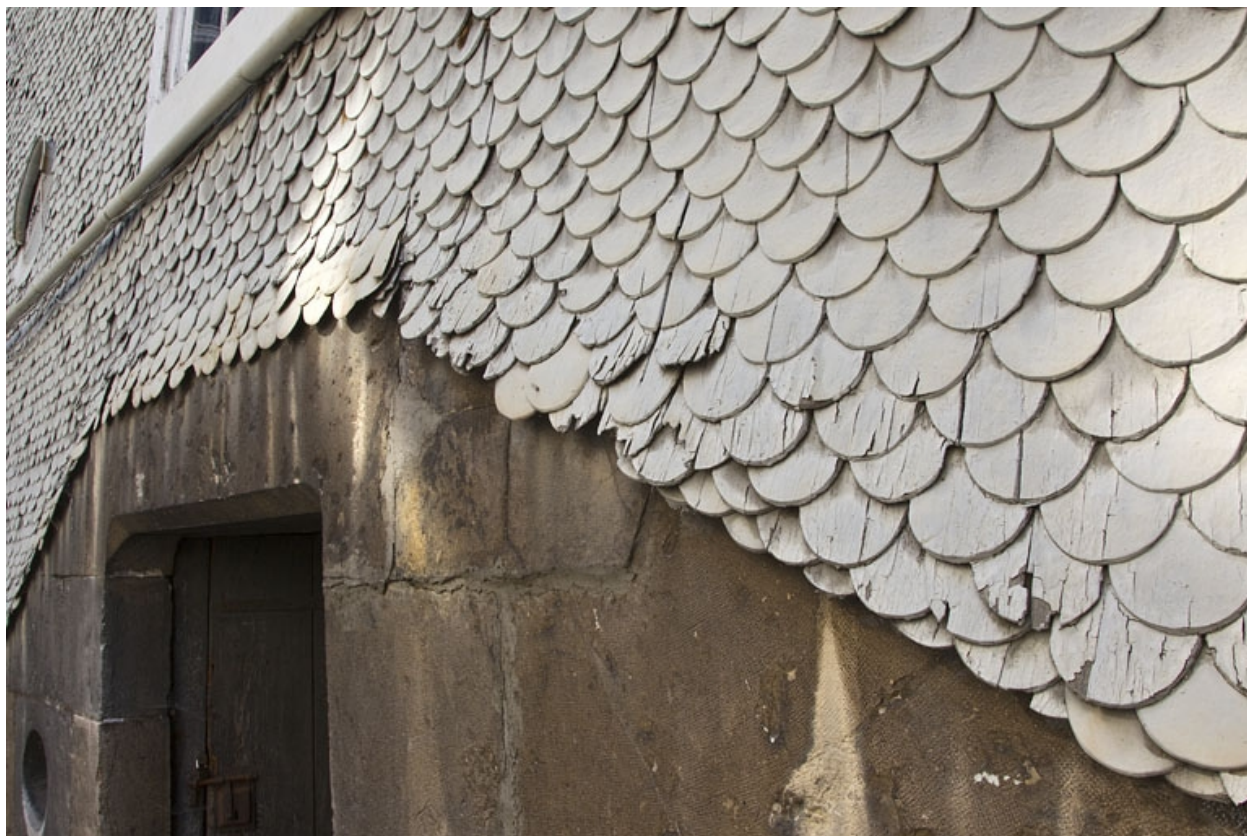
Détail des tavaillons recouvrant l'extérieur de la cage d'escalier.
