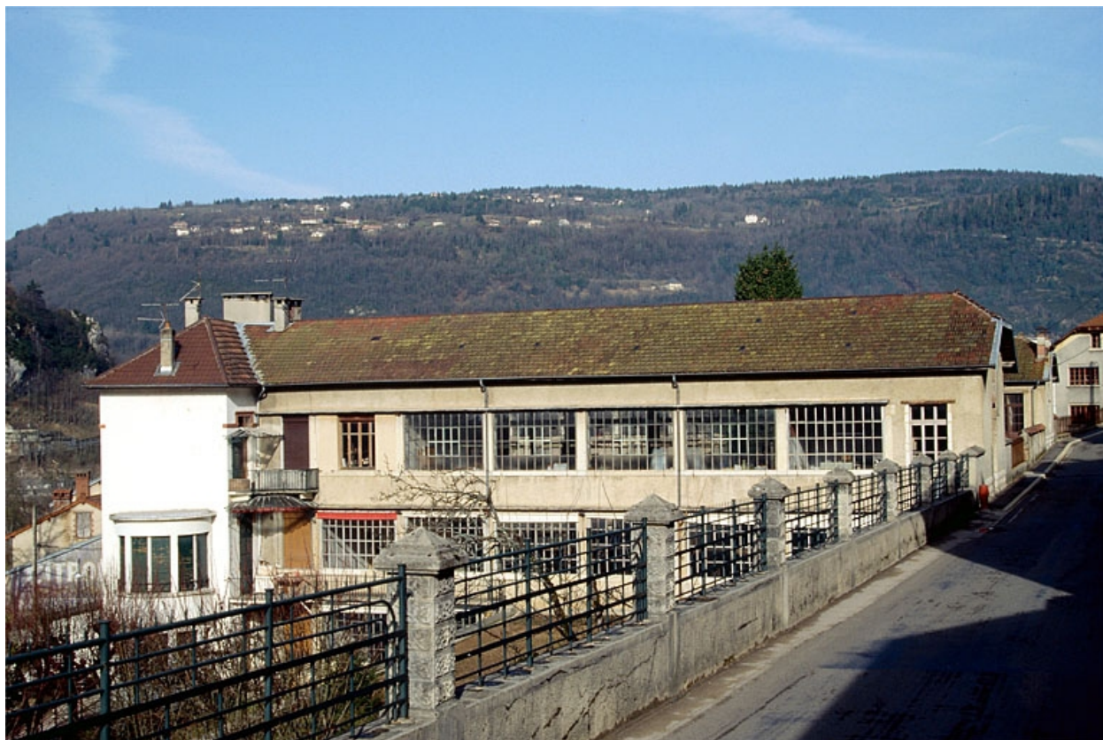
Façade latérale droite du 2e bâtiment.
