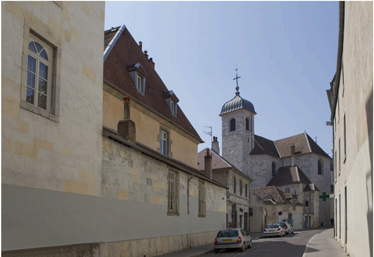
Vue d'ensemble des bâtiments depuis l'entrée de la rue de la Bibliothèque.
