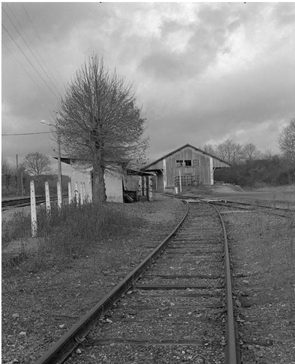
L'abri des voyageurs et le hangar
