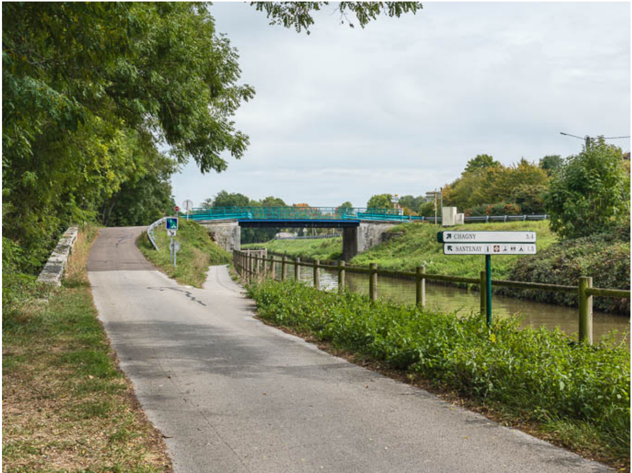
Vue d'ensemble du pont.
