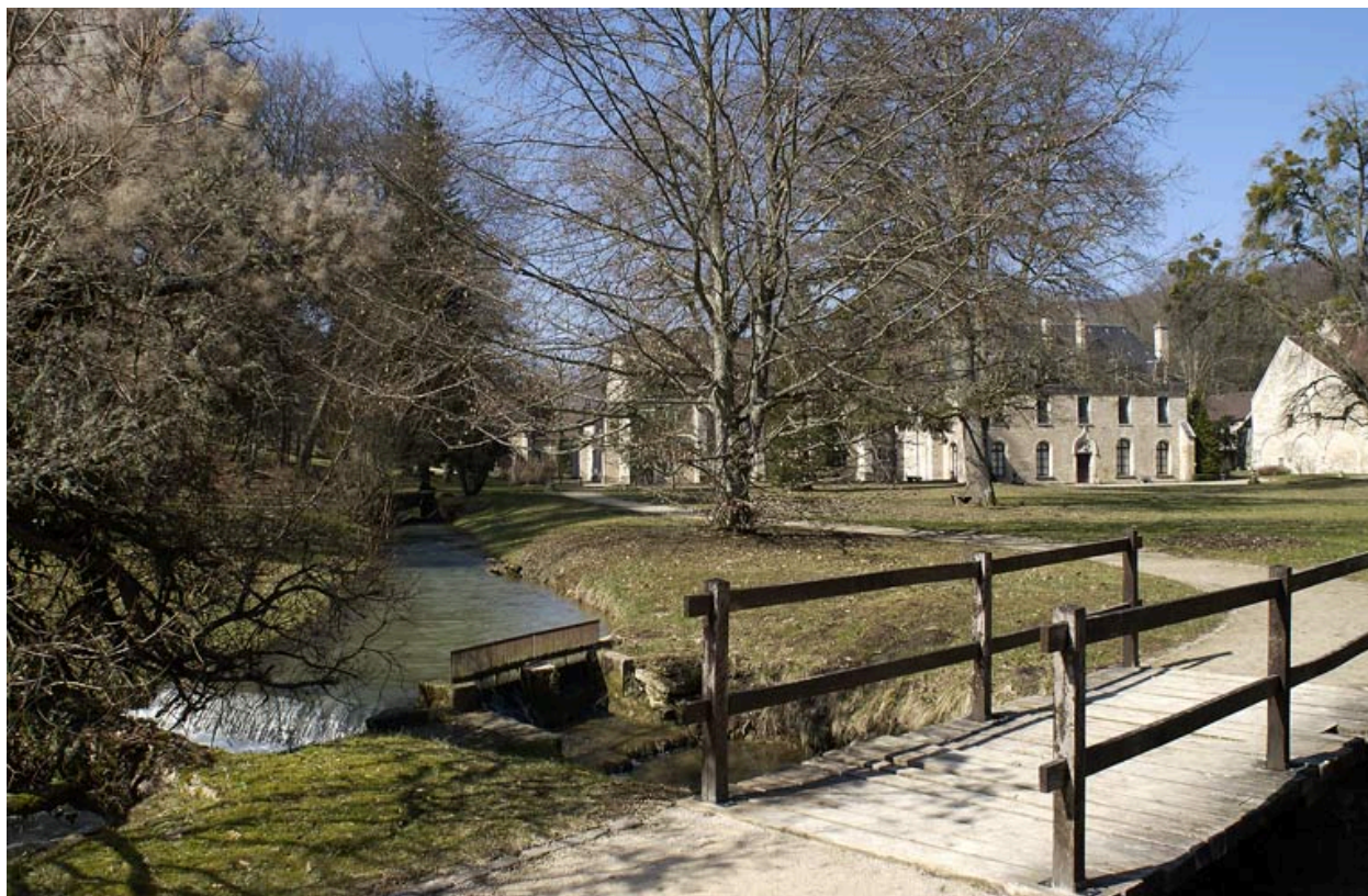
Vue du parc au sud-est des bâtiments conventuels.
