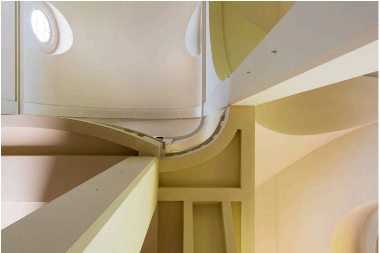
Couvrement de l'église à la jonction de la tribune, du vaisseau central et du bas-côté. Vue en contre-plongée.
