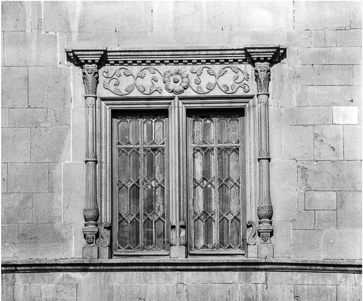
Façade sur rue. Détail : fenêtre centrale.
