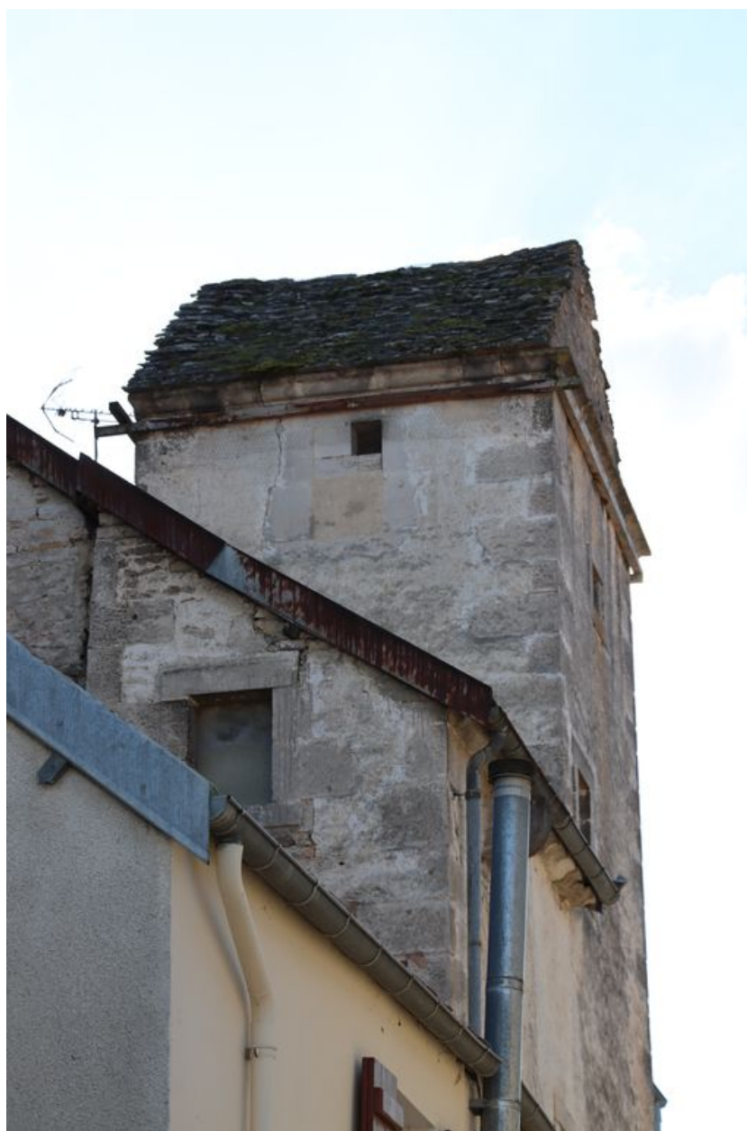
Vue de la tour d'escalier depuis l'ouest.
