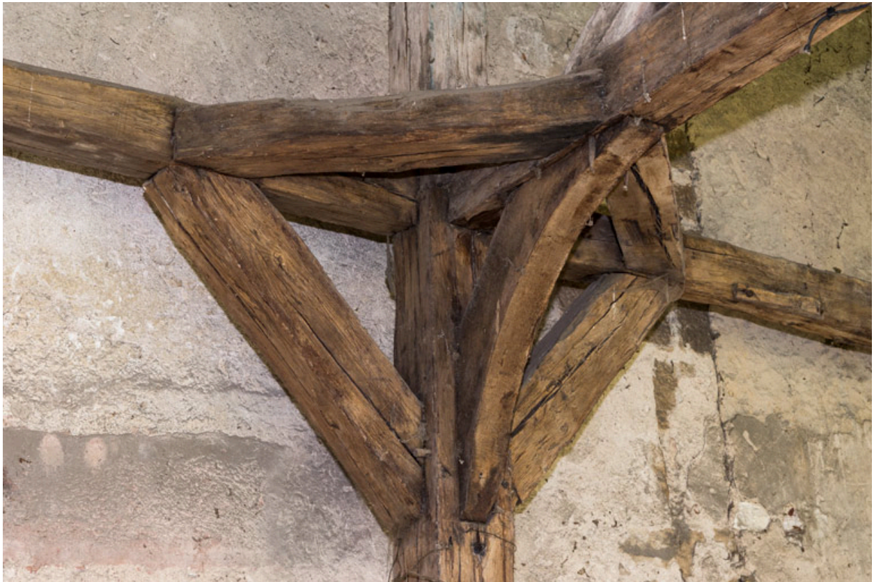
Ancienne halle : détail de la charpente.
