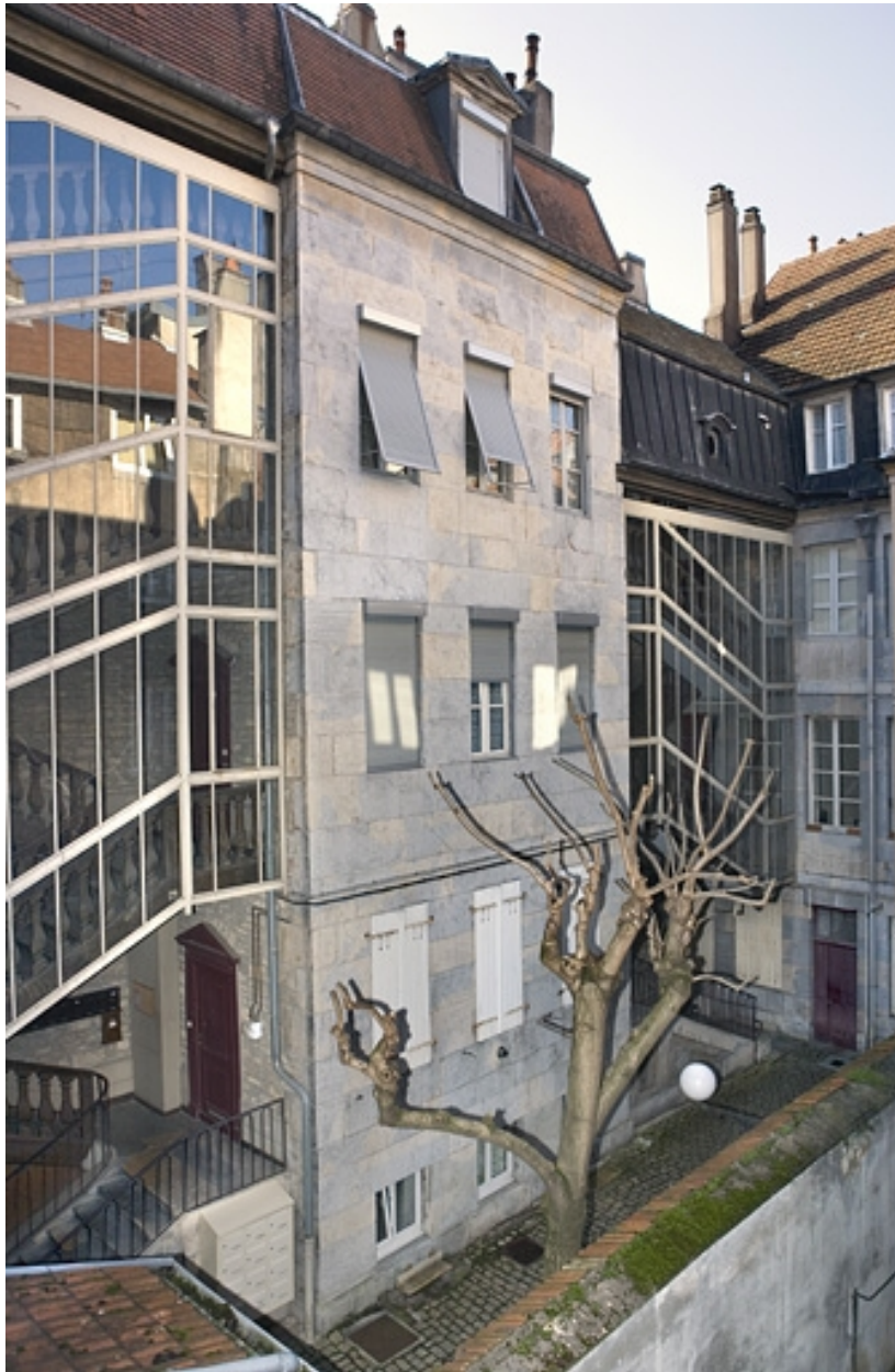
Vue d'ensemble du bâtiment encadrant les deux escaliers à cage ouverte situés dans la première cour.
