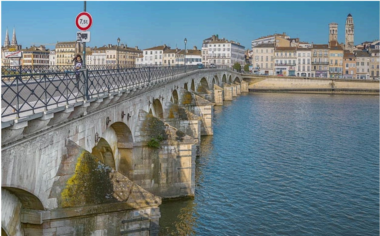
Les avant-becs du pont Saint-Laurent.
