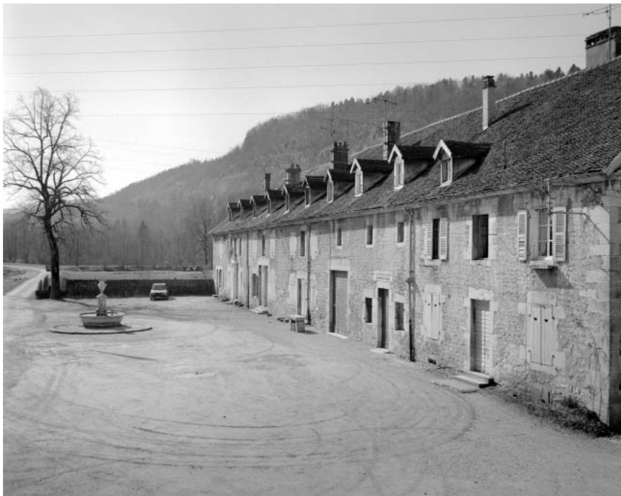
Logement d'ouvriers côté cour, vu de trois quarts droite.
