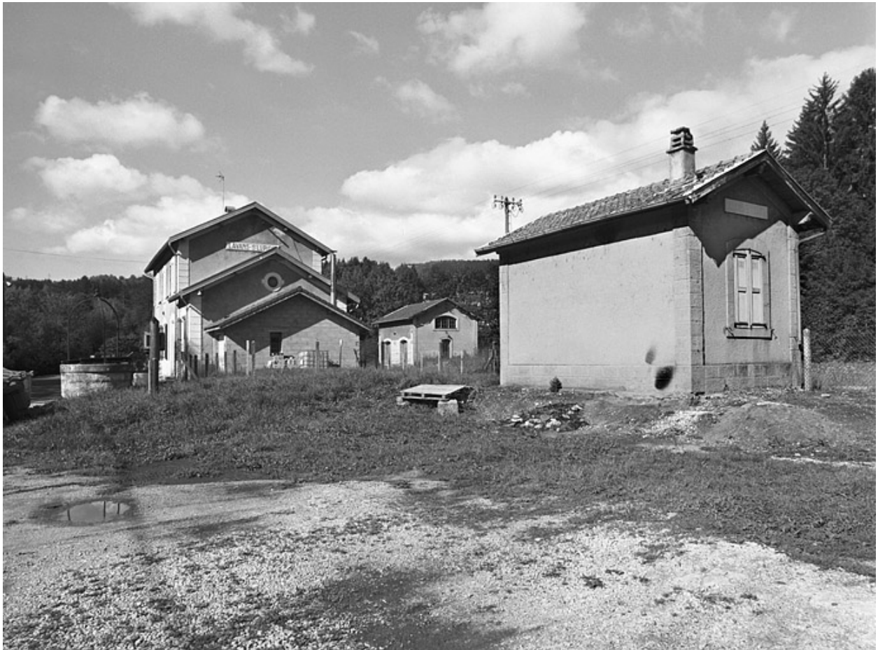
Vue d'ensemble des bâtiments, depuis le sud-est.
